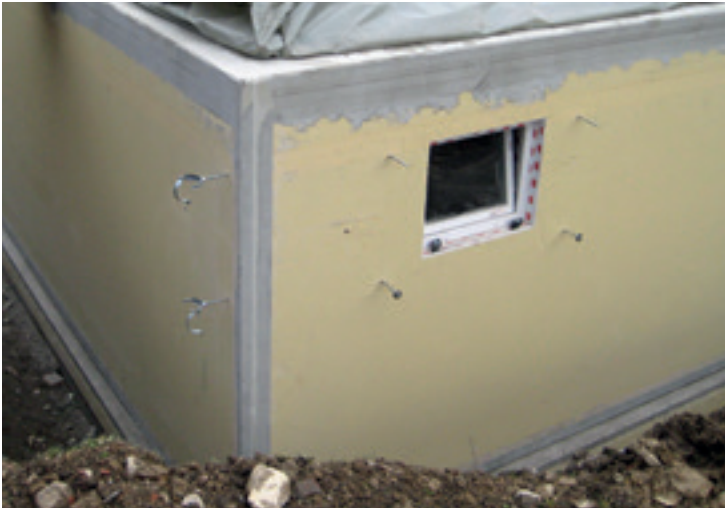
Übergänge als Detaillösung: Sikadur-Combiflex® TF System auf SikaProof® Gesamtsystem
